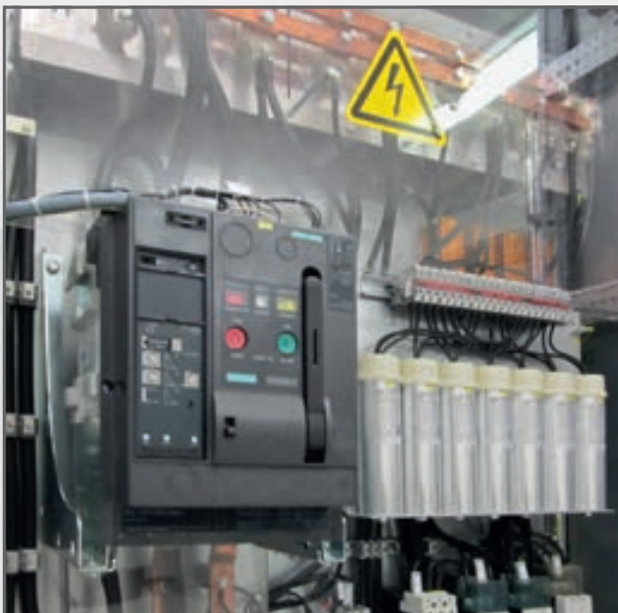
Statische Erregung im Kraftwerk Wahnhausen.
