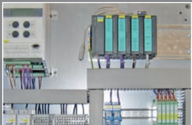
Saar-Kraftwerke – Spannungsregler für bürstenlose AC-Erregung.
