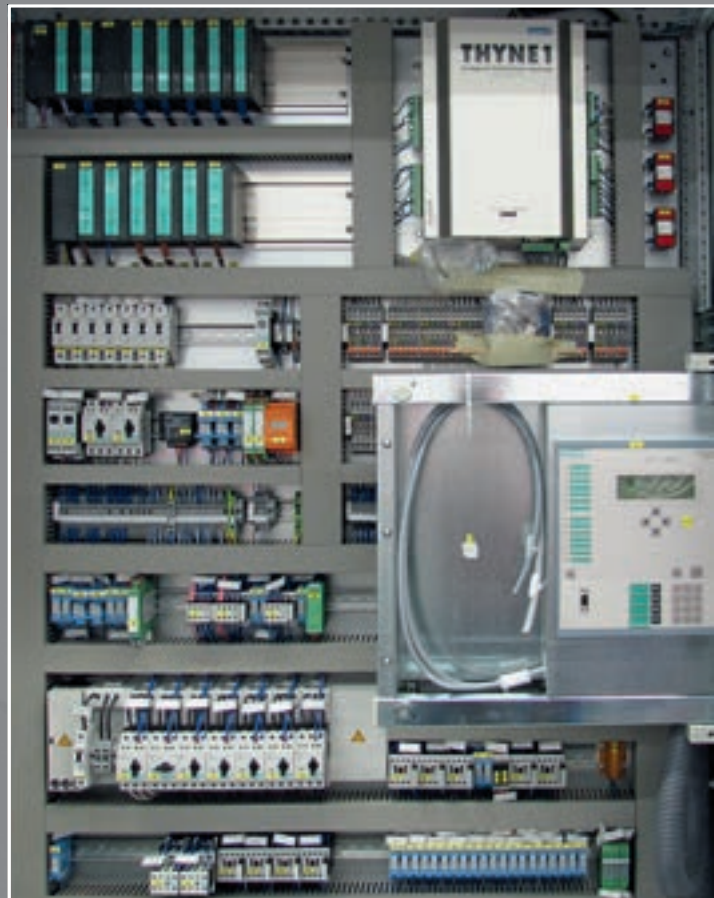
Dynamische Erregung im Kraftwerk am Höllenstein.
