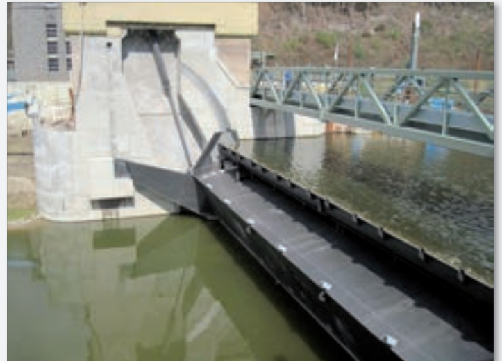
Abb. 9: Segmentschütz mit Klappe
