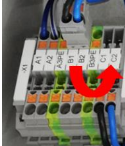
Abb. 8 - Stecker Klemmleiste X1
