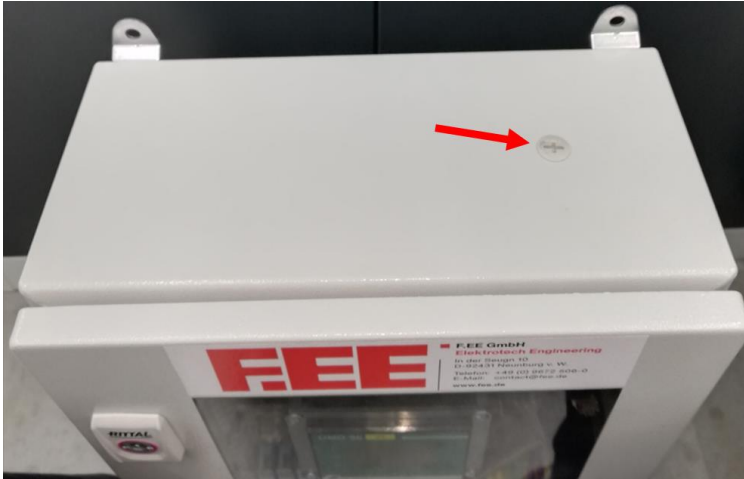
Abb. 4 - Montageort LTE-Antenne
