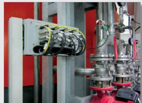
Abb. 3: Dezentrale E/As an den Kühlkreisläufen im WKW Wahnhausen
