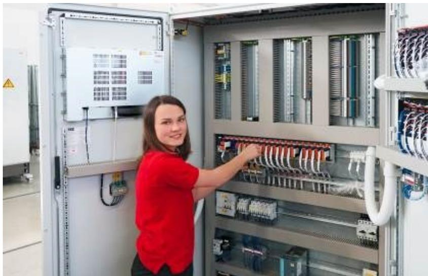
**Foto (F.EE): F.EE-Auszubildende bei der Montage und Verdrahtung einer elektronischen Steuerungseinheit eingebaut in einem Schaltschrank.**
